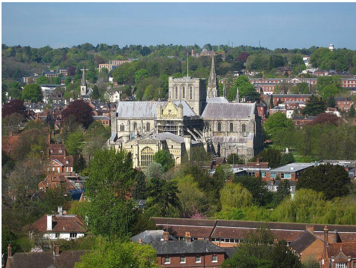
Winchester Cathedral, bygget fra 1079 og endeligt afsluttet 1532. Katedralen står på omtrent samme sted som de tidligere Old Minster og New Minster. ( Michael Coppins, Winchester Cathedral, from St Giles Hill, CC BY-SA 4.0 )
